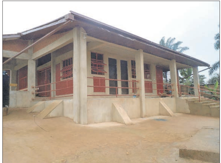
Das neue Gebäude wurde vorwiegend mit Lehmsteinen aus Eigenproduktion gebaut.
